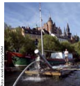
Utgrävningsplatsen vid Söder Målarstrand. En slamsug för upp material som ligger på vraket.
